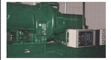
*Chambres froides positives et négatives, Vitrines surgelées, légumes, viandes, climatisation etc.. La salle des machines reçoit 6 compresseurs Man Europe hermétique. L'ensemble est conduit par un automate Texas instrument TI555 et supervisé par une console CVU100*
