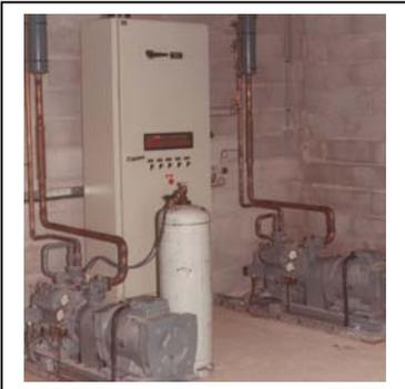
*Mûrissage en atmosphère contrôlée (CO<sup>2</sup>), environ 1hectare de chambres froides. La réfrigération par eau glacée, est assurée par deux compresseurs à vis, d'une puissance de 55KW. L'ensemble est conduit par un automate Texas instrument TI545 et supervisé par deux consoles CVU100*
